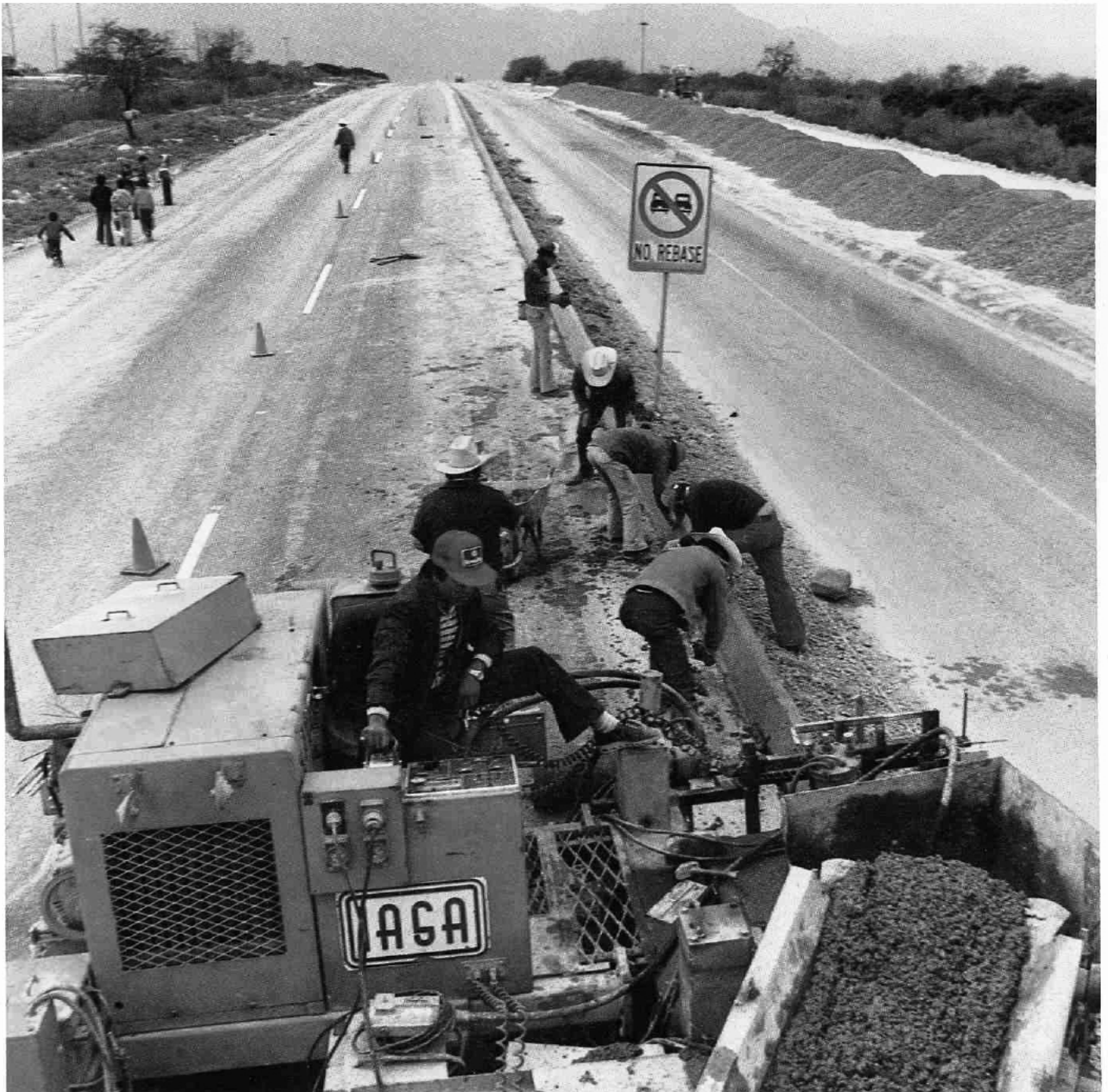
Personal y maquinaria de IASA en la carretera a Montemorelos, Nuevo León; en la página opuesta, a la izquierda; trabajos en la México-Toluca, cerca de la Marquesa, derecha, tramo en el camino Uruapan-Apatzingán, Michoacán.
